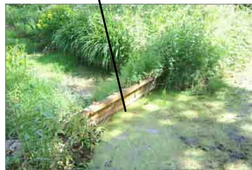
bestaande azobe keerwand om leegloop bestaande vijver tegen te gaan
